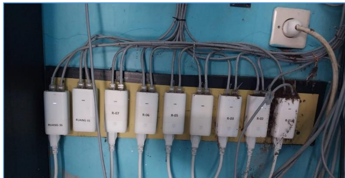
Gambar 3. Kondisi Perangkat Jaringan Karena Lembap
